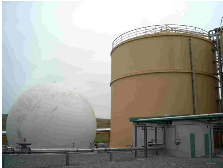
Foto 3: El tratamiento de residuos y el reciclaje son actividades que también generan puestos de trabajo. Almacenamiento de biogás en la Planta de Tratamiento de Residuos de Ávila.
