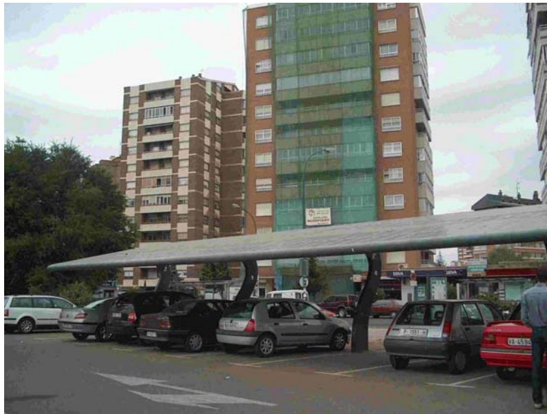
Foto 2: El diseño de este aparcamiento en un céntrico barrio de Valladolid permite la instalación de placas solares sin producir ningún impacto en el entorno urbano.
