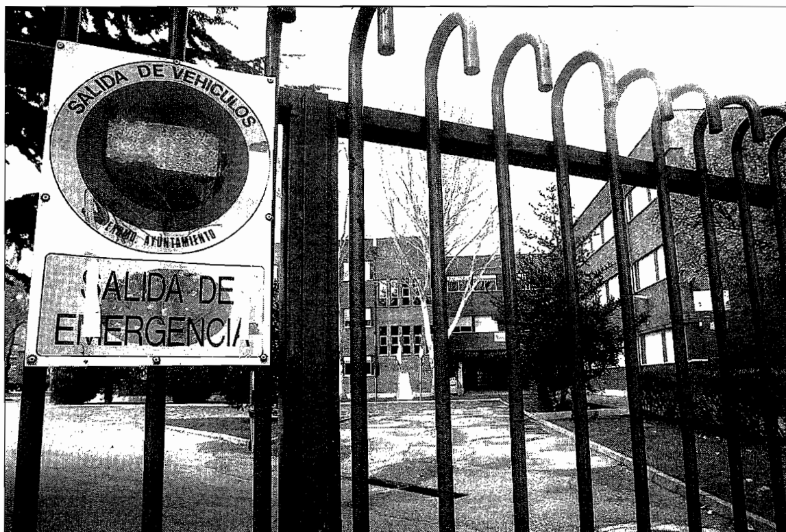
Puerta de entrada a un colegio de Valladolid que cuenta con salida de emergencia, pero no con vado. / EL DÍA DE VALLADOLID
